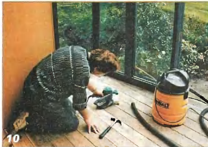
Подготовка пола к покраске.
