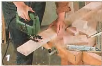
Вертикальные детали спинки выкраивают электролобзиком из березовой многослойной фанеры.
