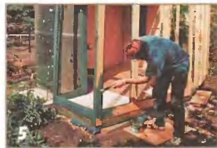
5 Деревянные детали обрабатывают цветным антисептиком.
