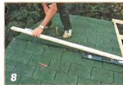
Укладывают пластины рубероида. Коньковая балка должна продолжать линию крыши, чтобы придать домику законченность.
