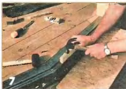
Порог облицовывают полосой из мягкого металла.
