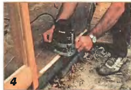
4 Четверть на дверном пороге выбирают фрезерной машинкой.
