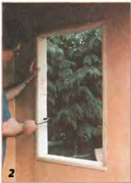
2 Оконные рамы прибивают и герметизируют силиконовым герметиком.
