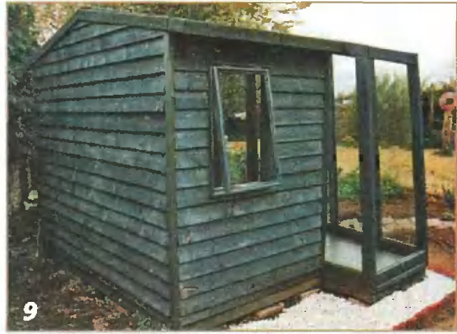
Если на садовый домик смотреть сзади, можно увидеть обшивку из досок внахлест и оконный проем.
