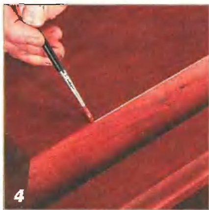
Окраска потертых ребер. Типичная ошибка — зачистка покрытой морилкой детали до древесины. Для ремонта поврежденное место подкрасьте кисточкой с акриловой художественной краской.
